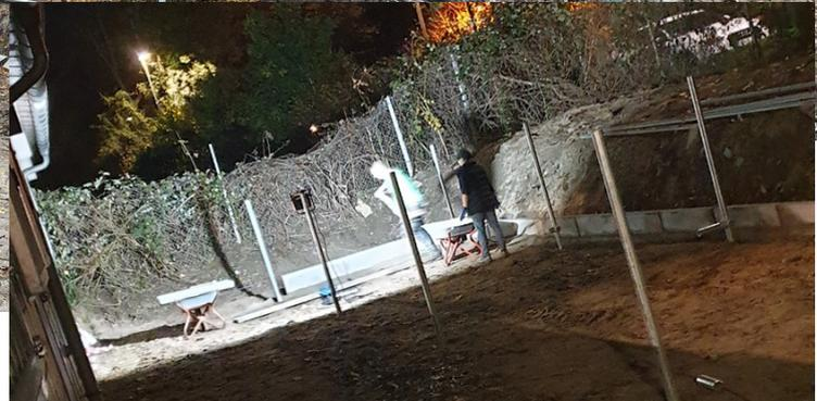
Am 26. Oktober wurde damit begonnen Schotter auf der Fläche zu verteilen und mit einer Rüttelplatte zu verdichten.
