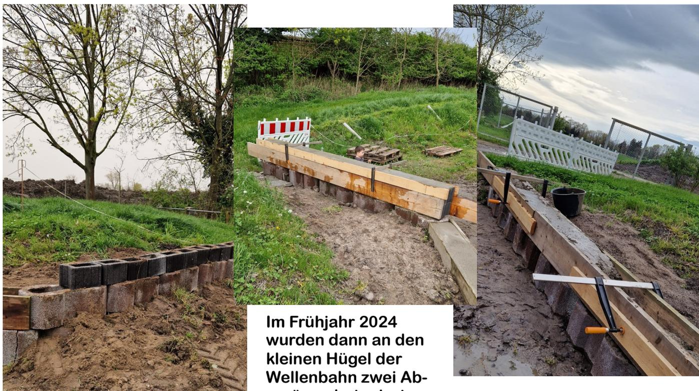
Im Frühjahr 2024 wurden dann an den kleinen Hügel der Wellenbahn zwei Absprünge betoniert
